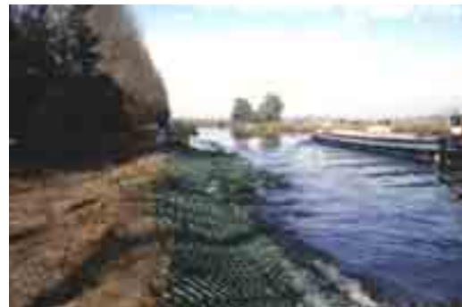
Fig. III-15 Protection de berge en système de confinement géoalvéolaire
