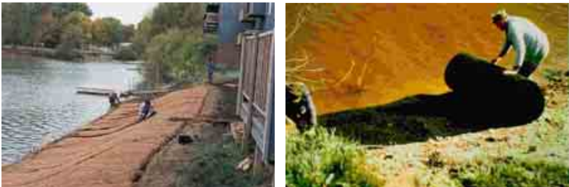
Fig. III-17 Mise en œuvre des protections de surface
