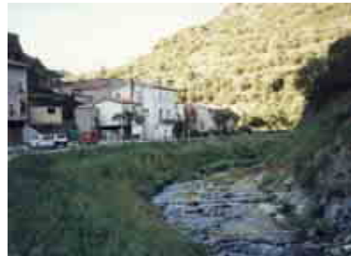
Fig. III-10 matelas tridimensionnels après végétalisation sur berge
