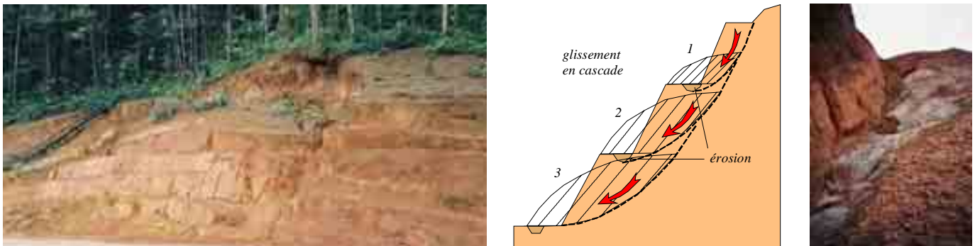
Fig. II-12 Erosion des talus au niveau des risbermes (route N2 , Guyane, 2002)
