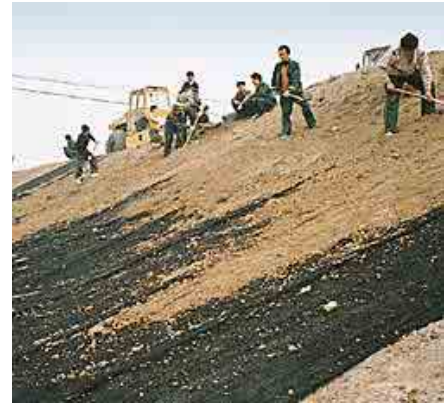
Fig. II-17 pose d'une géonatte
