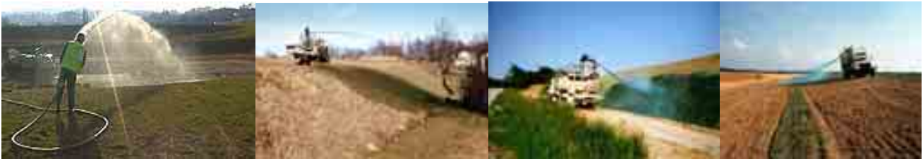
Fig. II-5 Le semis par projection hydraulique
