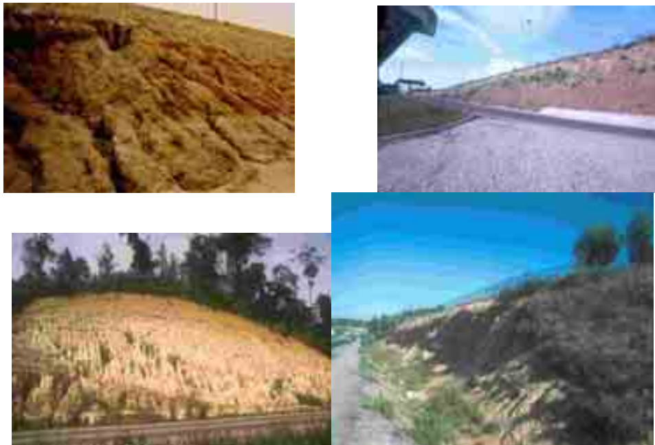
Fig. II-3 Exemples de talus routiers érodés
