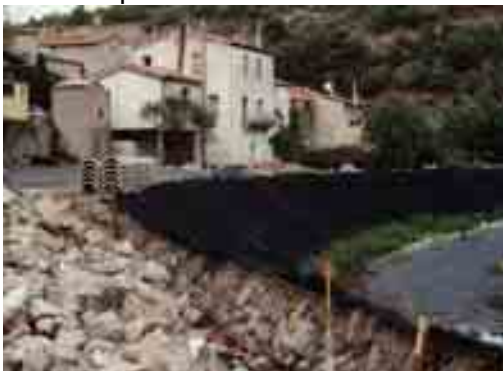
Fig. III-9 matelas tridimensionnels avant végétalisation sur berge
