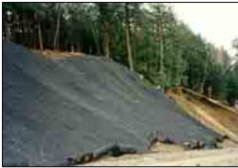
Fig. II-20 Géonatte en protection avant recouvrement de terre végétale
