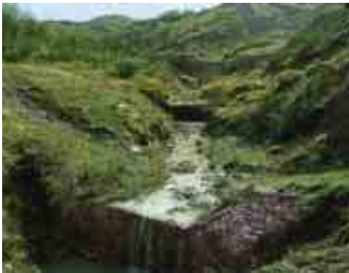
Fig. III-18 Seuils anti-érosifs en gabions métalliques et en géofilet
