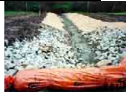
Fig. II-30 Protection des fossés par bionatte
