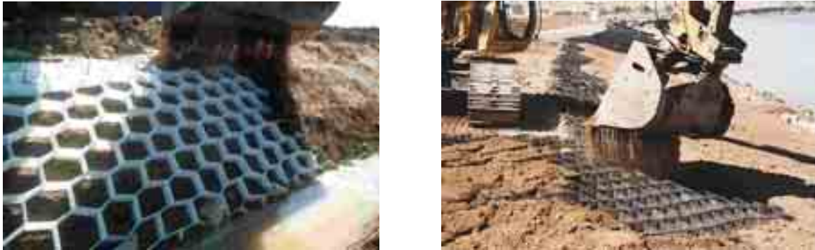
Fig. II-14 Mise en œuvre de géocellules en textile et en plastique
