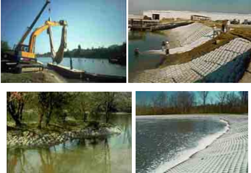
Fig. III-11 mise en place et exemple de protection par géoconteneur
