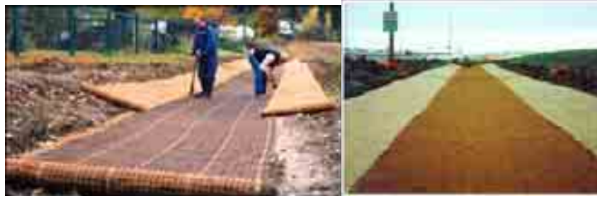
Fig. II-28 Protection des fossés par bionatte
