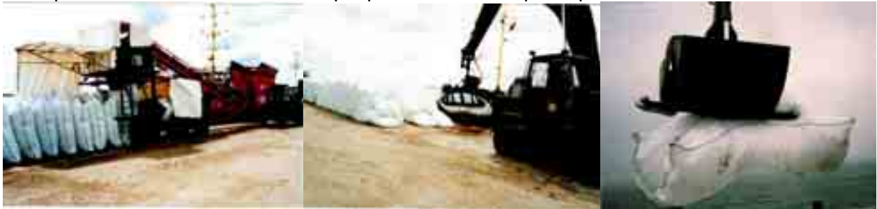
Fig. I-27 Remplissage et manutention des sacs de sable
