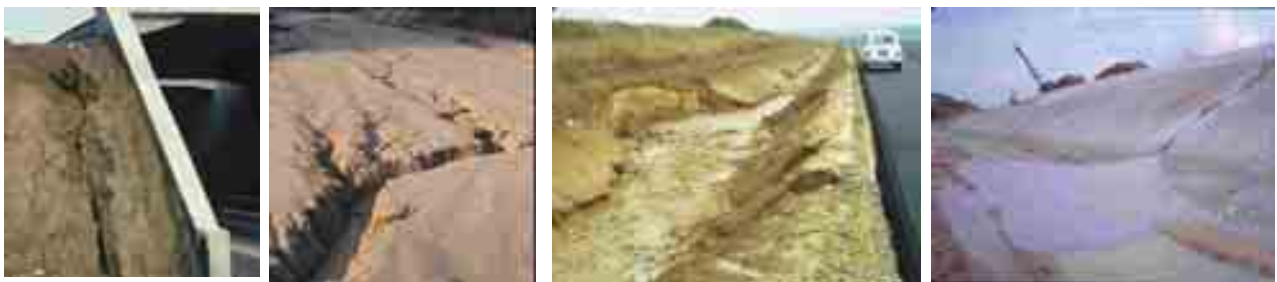
Fig. I-20 Exemples de travaux récents subissant l'érosion pluviale
