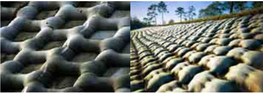
Fig. I-25 Exemples de conteneurs matelas
