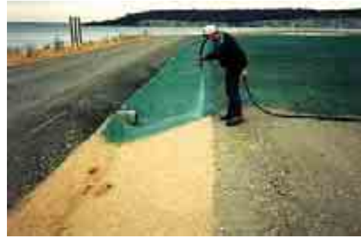
Fig. II-26 Ensemencement spécifique d'un fossé
