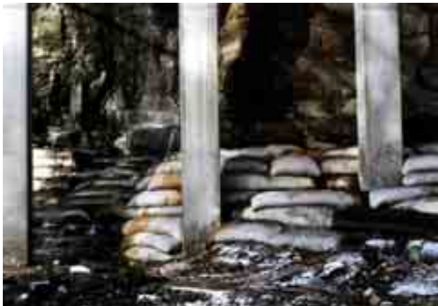
Fig. III-22 Protection de piles de pont avec des conteneurs.
