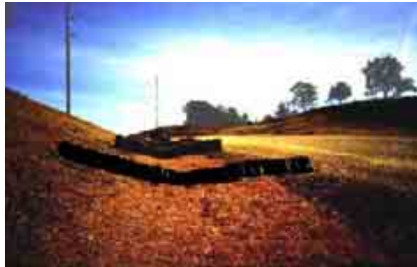
Fig. III-18 Seuils anti-érosifs en gabions métalliques et en géofilet
