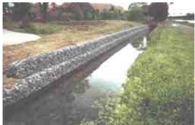
Fig. III-3 Protection de berge en gabion métallique
