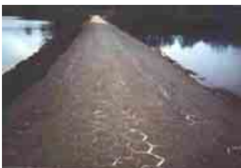
Fig. III-15 Protection de berge en système de confinement géoalvéolaire
