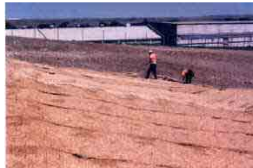
Fig. II-22 Mise en place d'une bionatte
