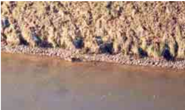
Fig. VI-4 Erosion d'une berge
