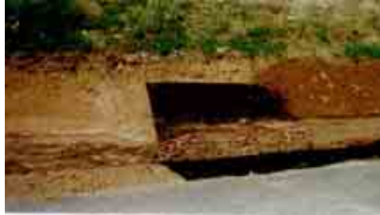
Fig. II-29 Protection des fossés par géonatte autoroute A83
