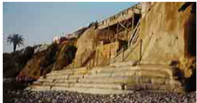
Fig. I-24 Protection de rivage en conteneur
