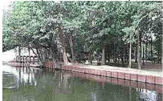
Fig. III-4 Protection de berge par tunage
