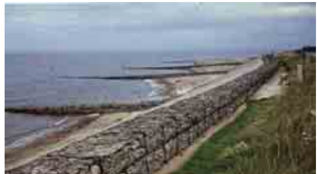
Fig. IV-11 Épis en enrochement et en gabions
