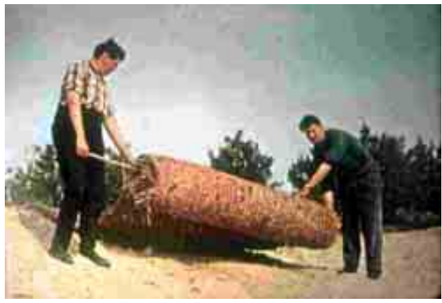
Fig. II-9 Pose de bionatte
