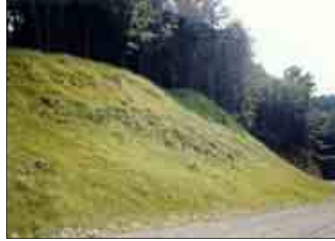
Fig. II-21 Végétalisation du talus après hydro-encroisement
