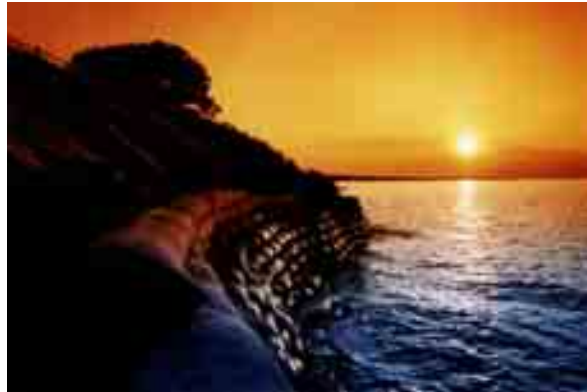
Fig. IV-8 Protection de haut de plage en sacs
