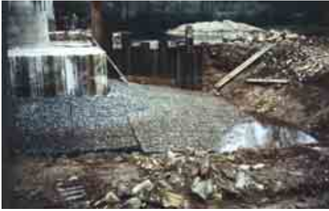
Fig. III-20 Protection de piles de pont avec des gabions matelas
