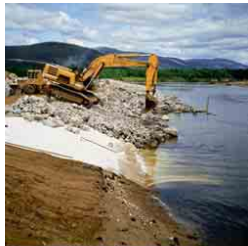
Fig. IV-9 Mise en place d'enrochements sur un géosynthétique
