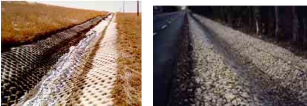
Fig. II-27 Protection des fossés par géoconteneur de type matelas
