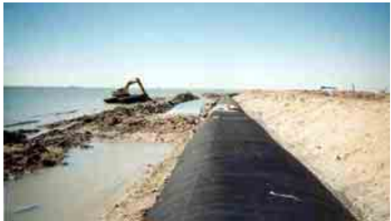
Fig. IV-12 Épis et brise lames en conteneur
