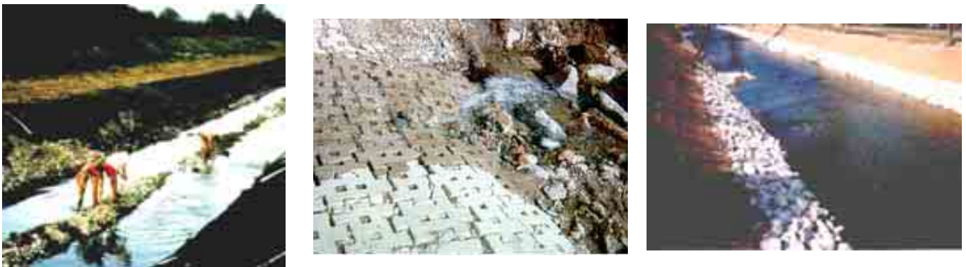
Fig. III-5 Protection de la berge sous une couche de protection
